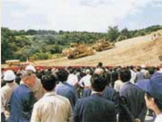
1988年9月 福島空港建設起工式
