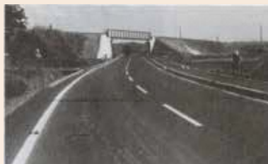
1973年3月 国道118号全線改良工事完了
